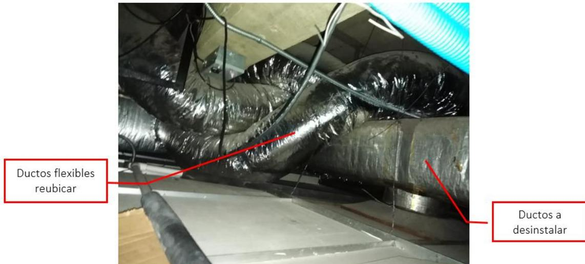
*Figura. Muestra los ductos del sistema antiguo (fuera de uso) y el nuevo sistema con ductos flexibles.*
