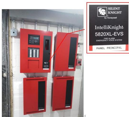
**Figura.** Panel de control existente ubicado en el sótano.
